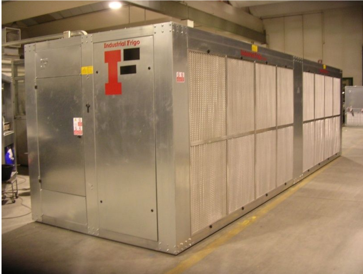
Алюмінієвий повітряний фільтр легкодоступний для сушки та чищення
